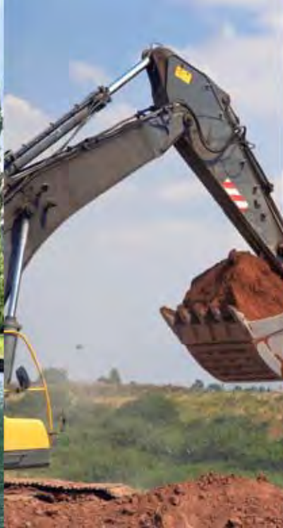
ÜBERWACHUNG VON SANIERUNGEN
